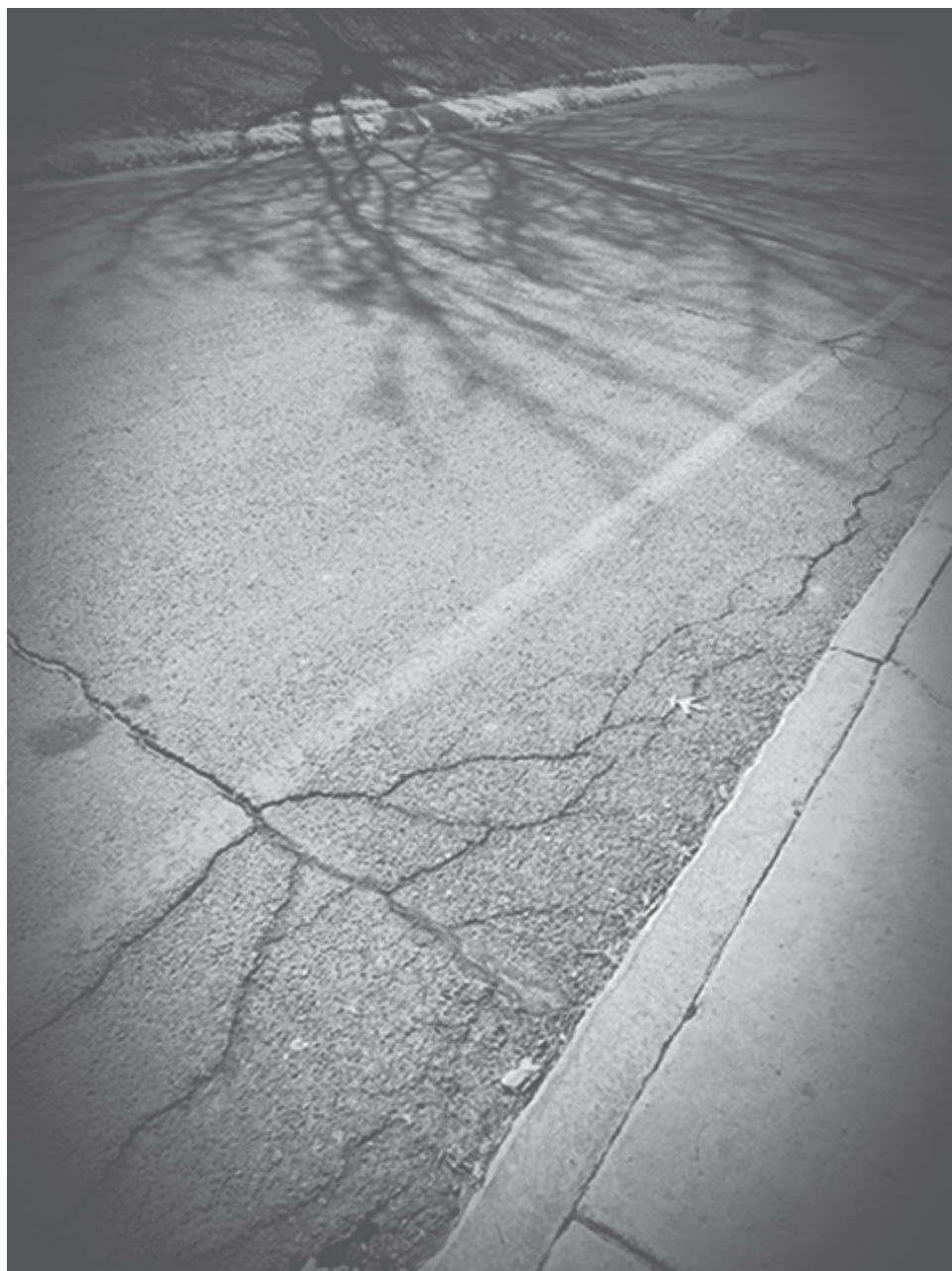
Alla Boldina | Concrete Roots I
